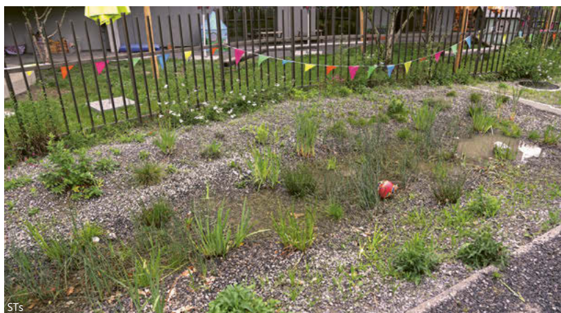
Retentionsbecken (Stöckacker Süd)
